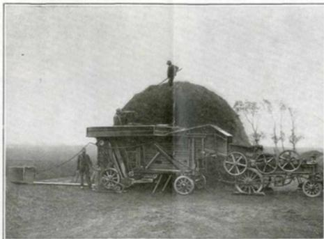
Fig. 5. — Battisse du type extérieur avec compresseur de paille. Moteur transportable alimenté par câble flexible.
